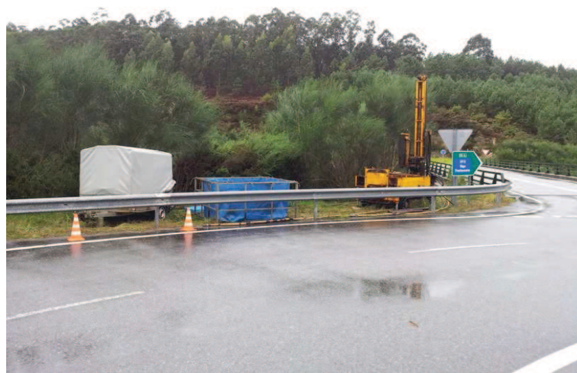
Sondeo: S-1 EMPLAZAMIENTO
